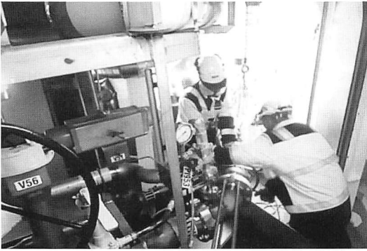
バイキンググレースのLNGバンカリング作業
